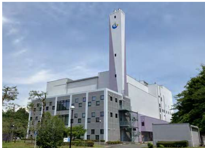
清掃工場外壁改修・屋上防水工事
