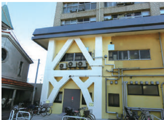
耐震補強工事/ピタゴラム工法
