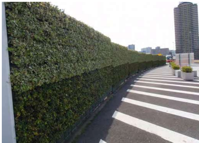
首都高速道路 PA壁面緑化維持
