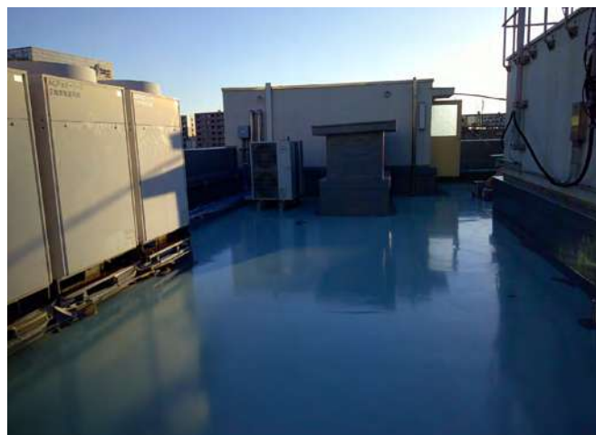
首都高速道路 換気所防水工事
