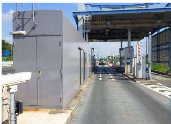
首都高速道路 料金所外装塗装
