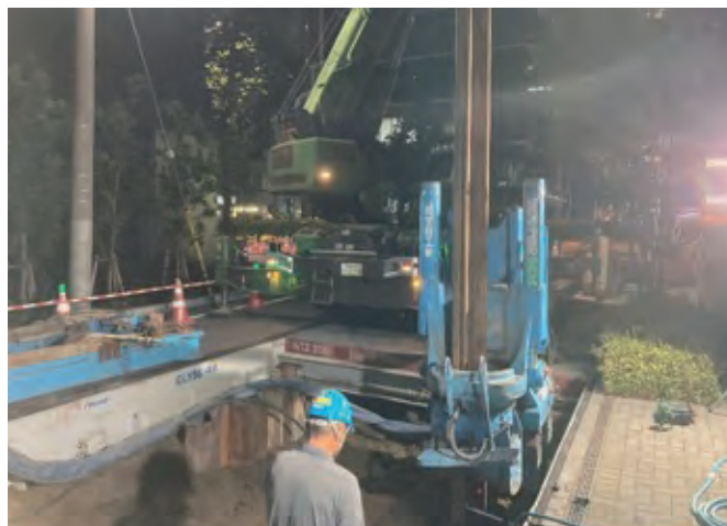
鋼矢板打設(夜間施工)
