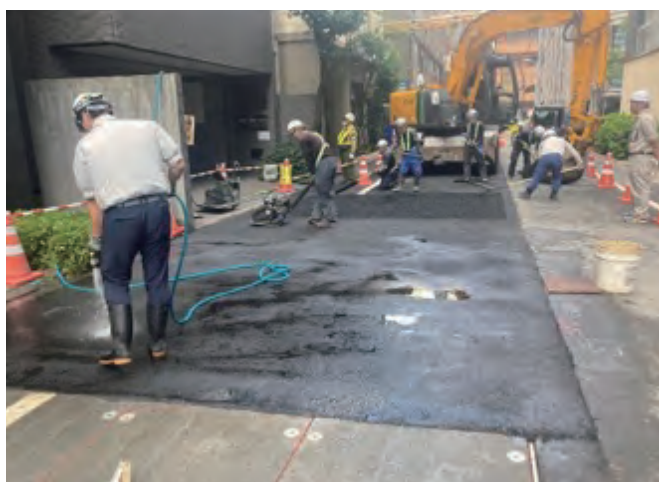
復旧舗装状況
