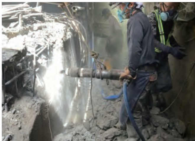
構造物取壊し
